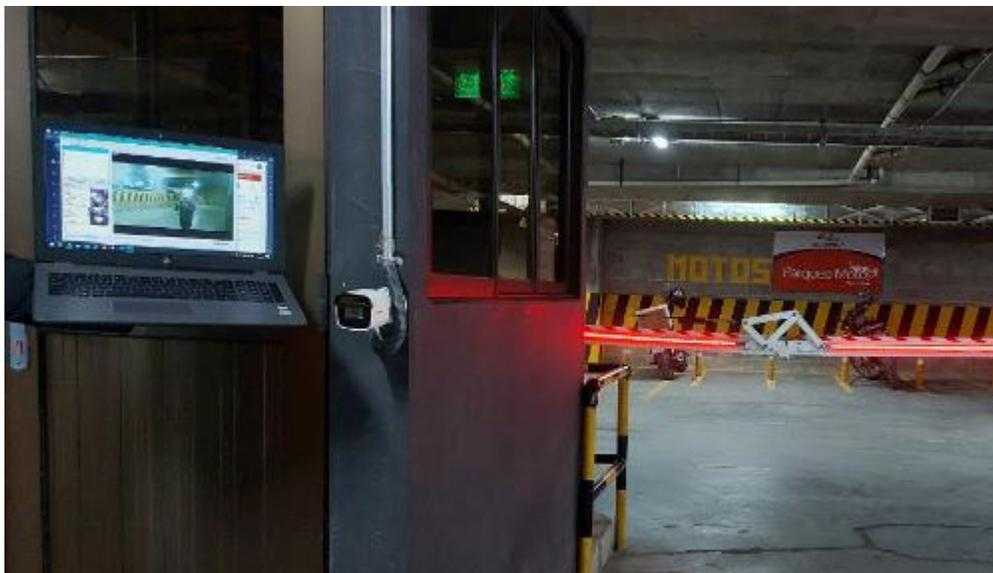
Se implementó la cámara IP, para el funcionamiento del registro automático en el estacionamiento con el cableado correcto y la posición de la cámara que van de manera correcta, logrando así tener la conexión establecida con el internet.
