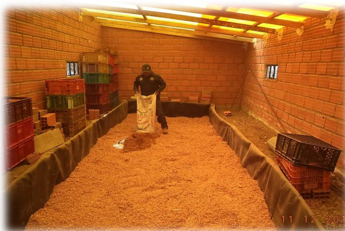
Figura 7. Colocado de capas filtrantes
