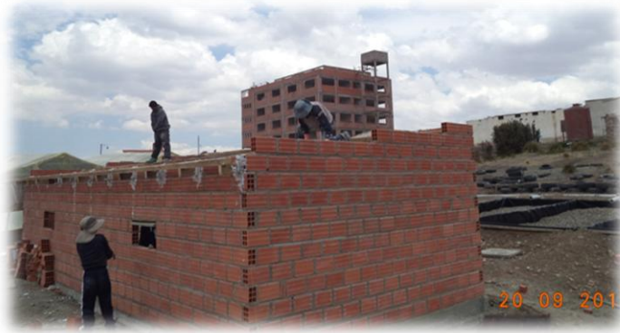
Figura 5. Construcción del ambiente atemperado
