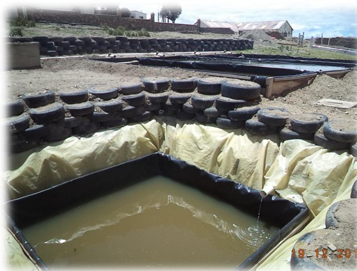
Figura 9. Agua filtrada que alimento de aguas servidas al biofiltro
