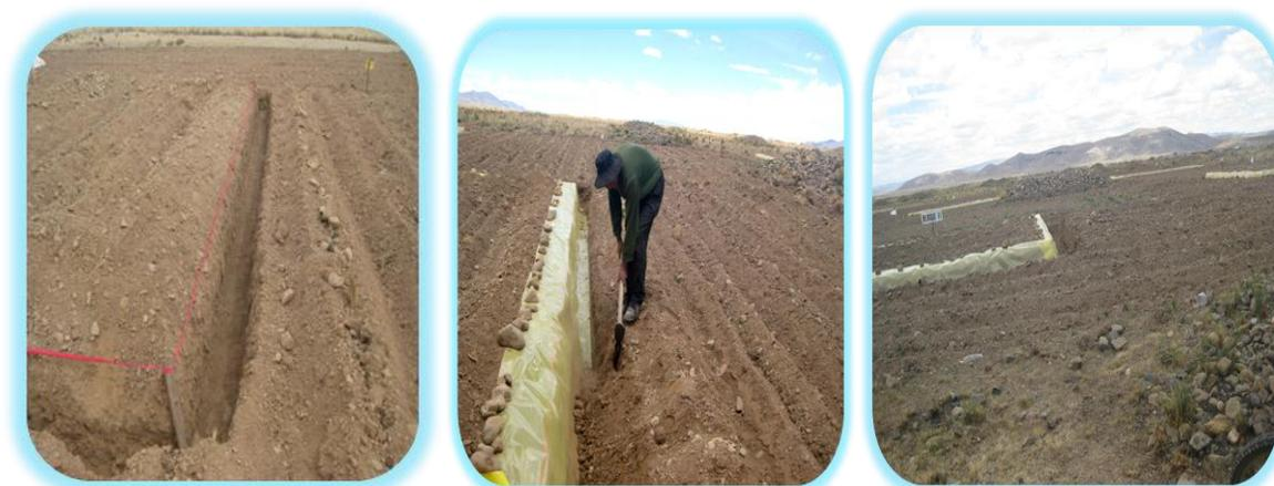
**Figura 9. Cavado, tendido y posterior sellado de la barrera**
