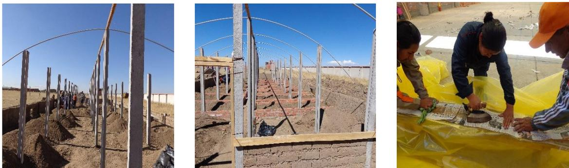
**Foto 3.** Instalación del ambiente atemperado, con muro de adobe, viguetas plantados para el soporte de la cubierta y la realización del planchado del agrofilm, para el techado.
