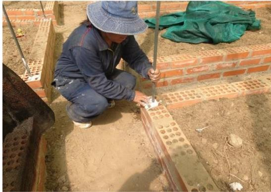
**Foto 2.** Instalación de las mallas raschel de 50%, 65% y 80% de densidad para cada tratamiento
