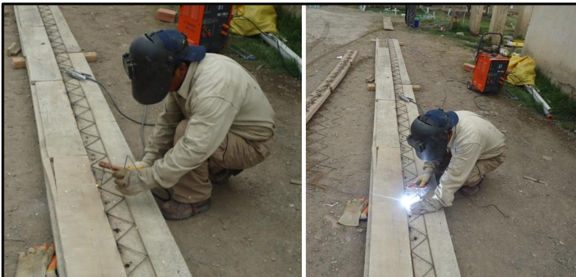
Figura 6. Construcción de la celosía
