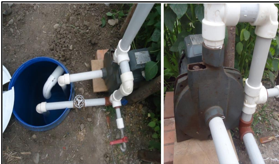
Figura 7. Instalación del sistema de riego
