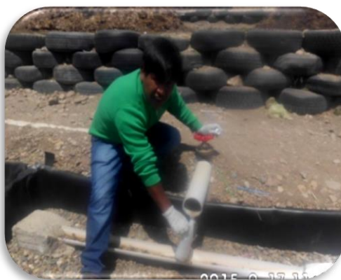
Figura 17. Toma de muestra de agua en la entrada de los estanques artificiales de ensayo
