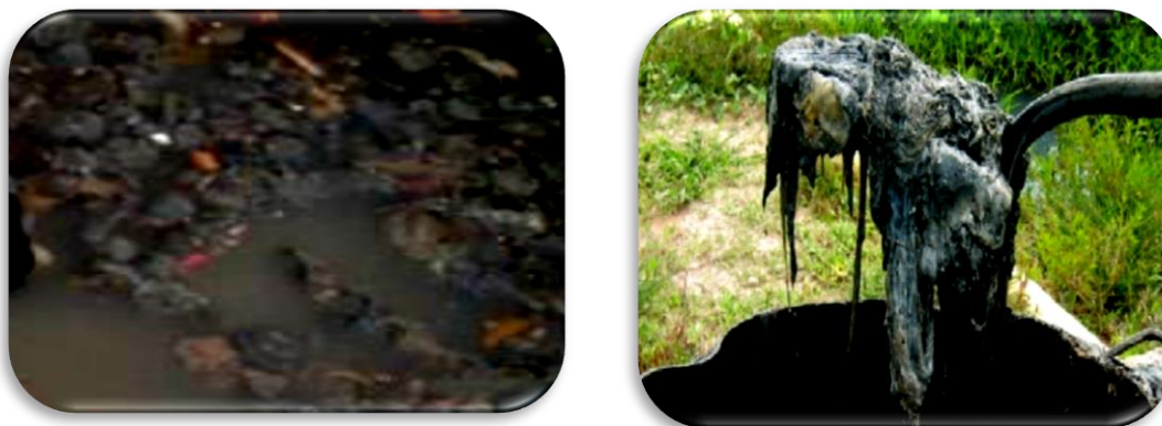
Foto 2. Cámara de rejilla con elementos gruesos como ser bolsas plásticas, envases de champú, preservativos y toallas femeninas.
