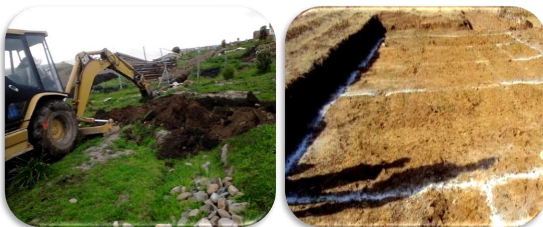
Figura 1. Nivelación del terreno donde se instalaron los estanques artificiales de ensayo
