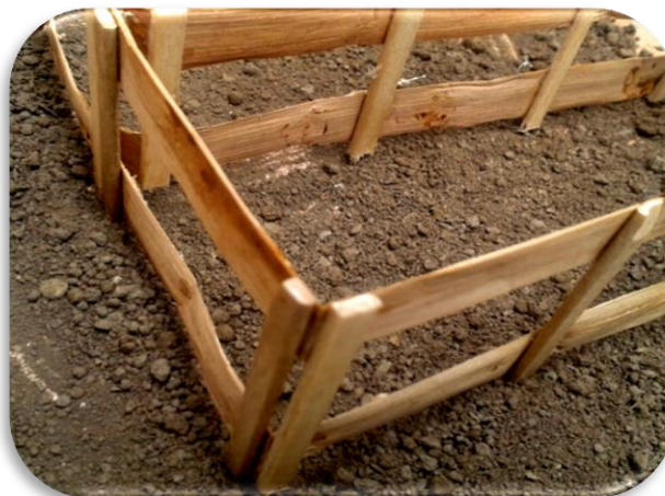
Figura 3. Detalle del armado de los tabloncillos de los estanques artificiales de ensayo
