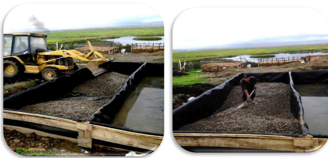
Figura 5. Rellenado de los estanques artificiales de ensayo con grava de \frac{3}{4}
