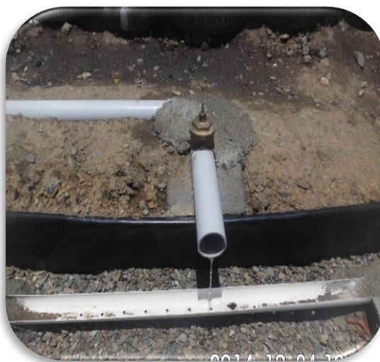
Figura 14. Proceso de llenado de los estanques artificiales de ensayo
