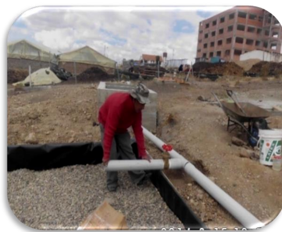
Figura 12. Colocado de los tubos de distribución de las aguas residuales a los estanques artificiales de ensayo
