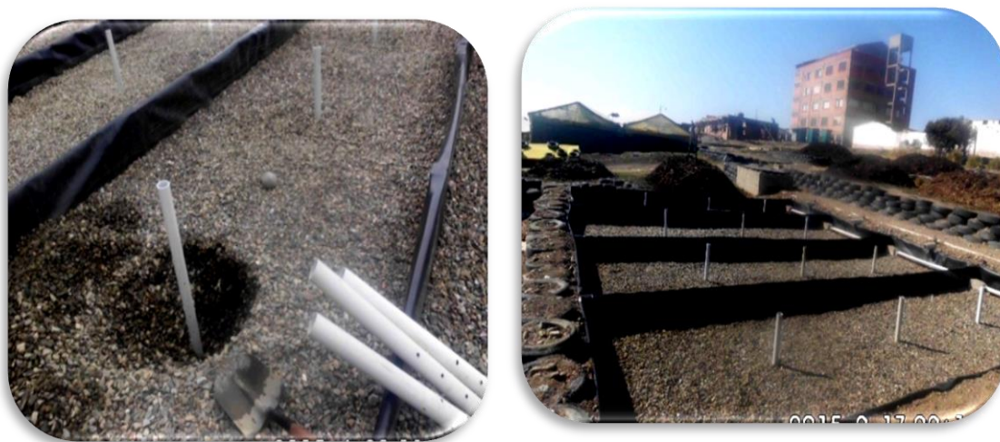
Figura 8. Estanques artificiales de ensayo terminados de construir y instalado de tubos de aireación
