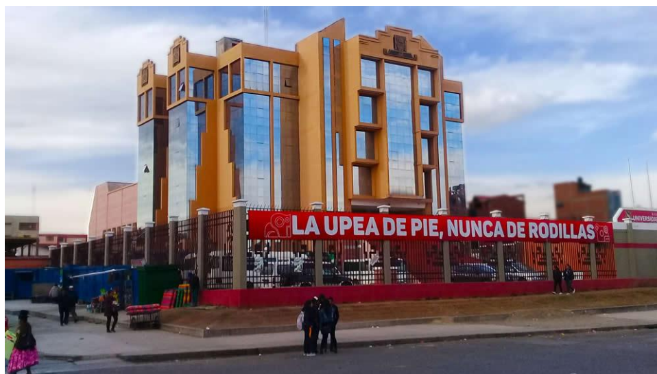
Figura N°3: Edificio emblemático de la UPEA
