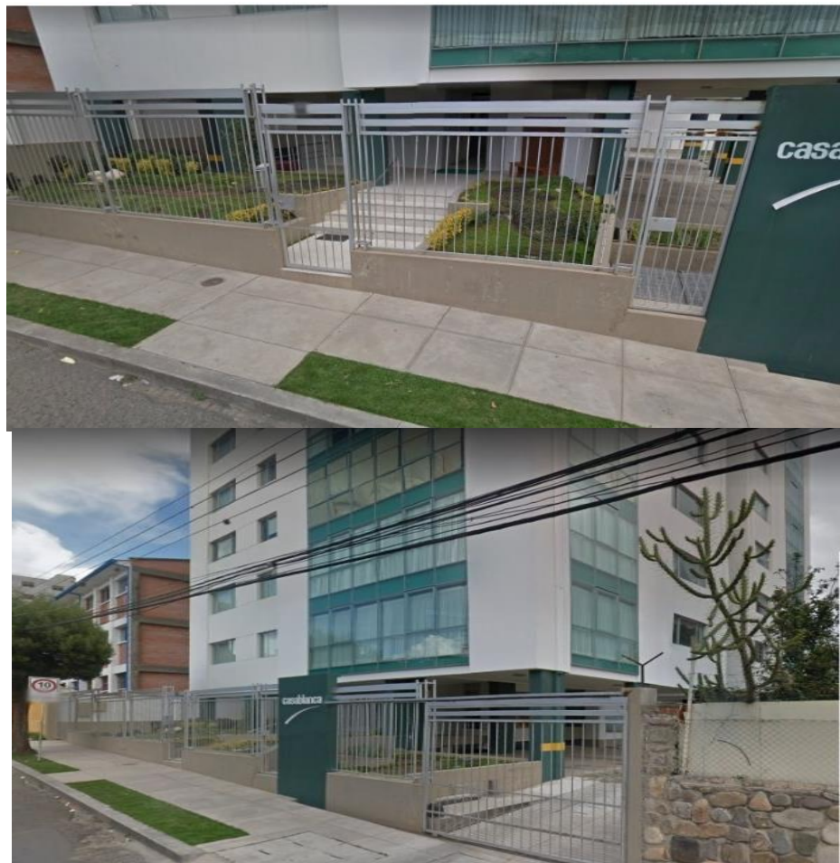
Fotografía N° 1. Puerta principal Edificio Casa Blanca
