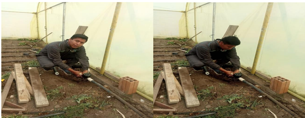
Figura 8. Instalación del sistema de riego
