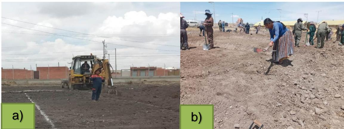
**c)** La división de bloques consiste en medir y delimitar los terrenos, asegurando una distribución precisa y organizada del espacio; **d)** El sacado de zanja en el terreno consiste en excavar canales de profundidad para proteger inundaciones en tiempo de lluvia
