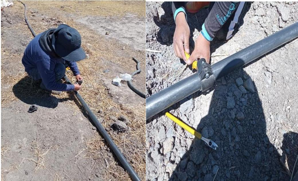
**Figura 4. Instalación de collarines en la tubería principal**
