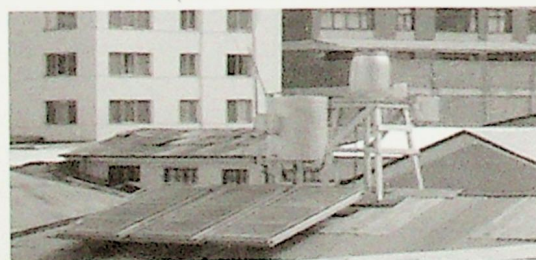
Fotografía 3. Colector solar plano con rejilla de tubo de cobre – La Paz. (Fuente: Falk Solar - Infocal)
