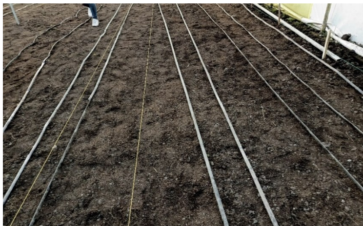
Figura 8. Instalación de sistema de riego por goteo
