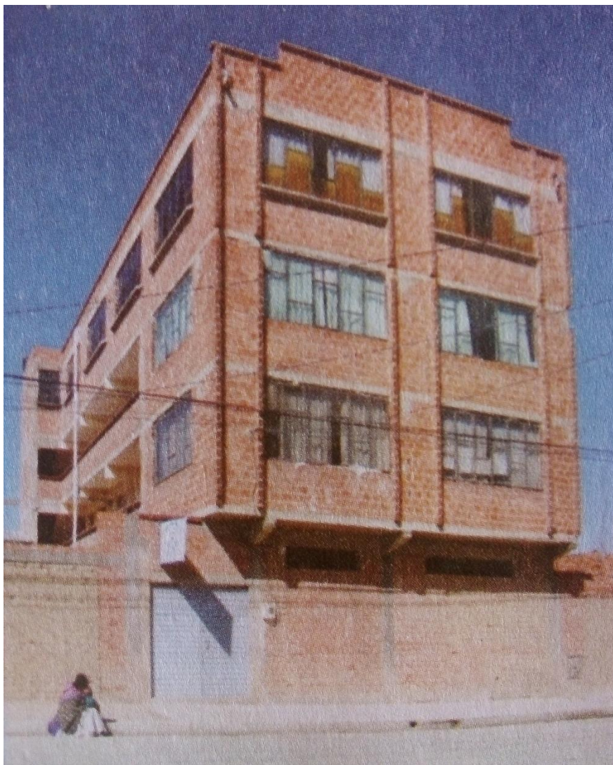
Foto N° 1. Edificio de la Iglesia Armonía.
